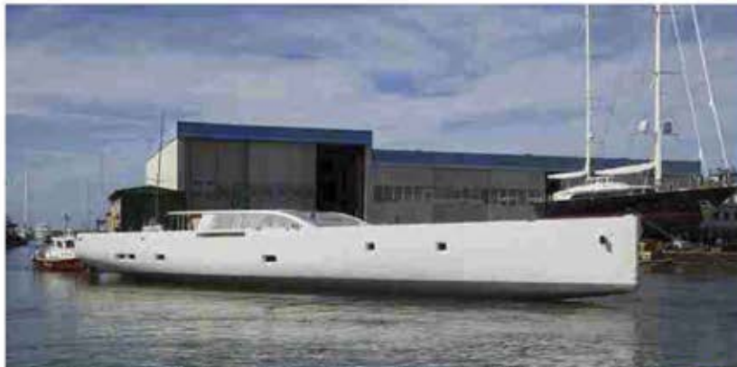
In Viareggio im Bau: zwei 42 Meter lange Aluhüllen aus der neuen E-Volution-Serie. Am türkischen Standort Tuzla schweißt Perini an zwei weiteren Segelyachten aus der E-Volution-Linie (47m, 42m, on spec).
