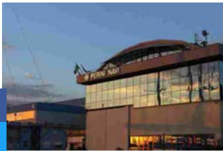
Il cantiere di Viareggio di Perini Navi
