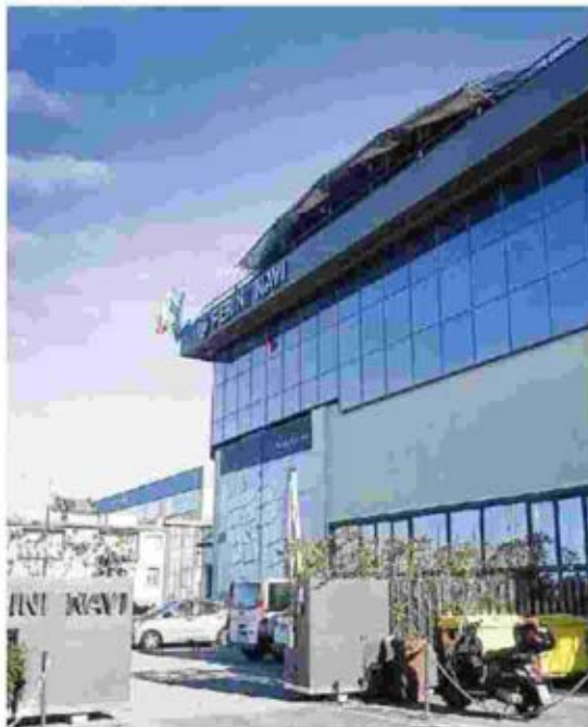
Il cantiere Perini a Viareggio FOTO ARCHIVIO
