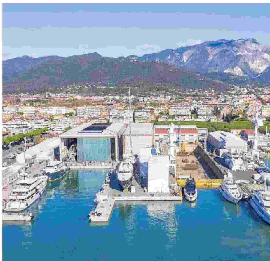
Una veduta del cantiere di Marina di Carrara
